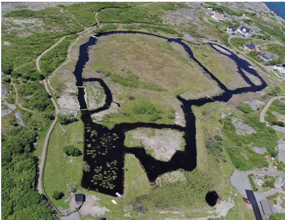
Fig. 5. Övre bilden visar bland annat grävda kanaler som vuxit igen med bladvass och viden innan restaureringen påbörjades 2020 i LONA-projektet. Nedre bilden visar området 2022 efter genomförda åtgärder. Notera att det redan i övre bilden från 2020 utförts omfattande röjningsåtgärder i områdets södra och västra delar. Foto: Dan Calderon och Peter Post
